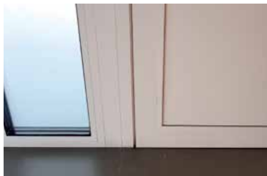
Zonas transparentes envidraçadas com vidro triplo de 58 mm
