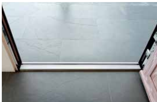
Remate de solo plano para manter a estanqueidade ao ar
